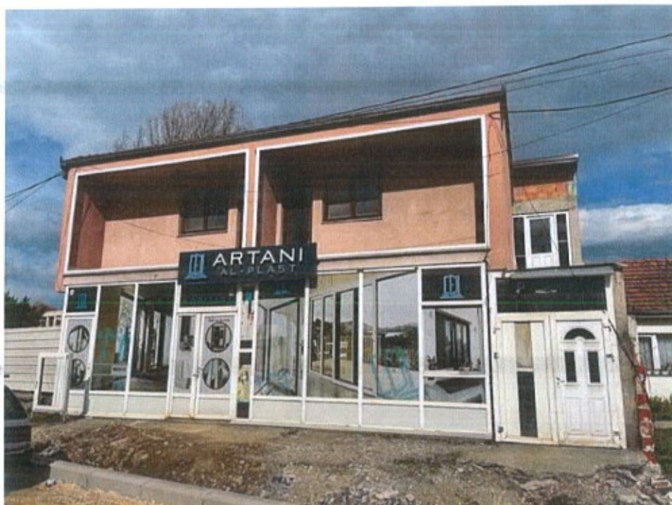
Foto 2. Foto e fasadës perëndimore të objektit afarist, mars 2023
