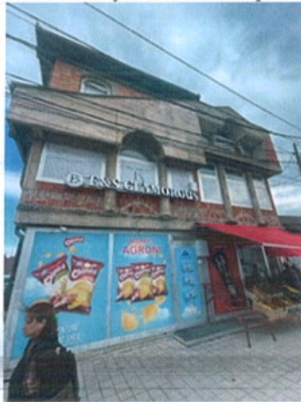
Foto 2. Foto e fasadës perëndimore të objektit afaristo-banesor, mars 2023
